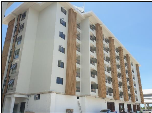
รูปที่ 3-10 ผนังอาคารจากพื้นจนถึงเพดานชั้นก่อสร้าง ทำหน้าที่เป็นกำแพงกันเสียง
