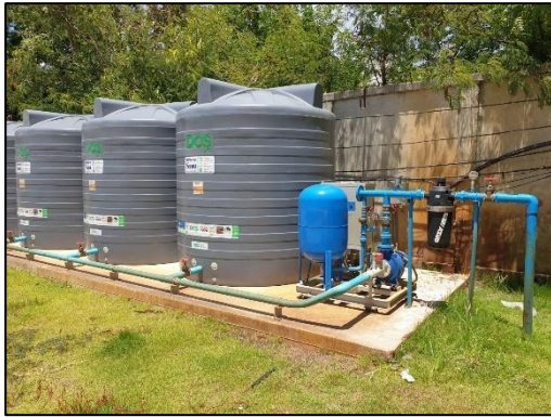
รูปที่ 3-12 จัดให้มีถังสำรองน้ำใช้ให้เพียงพอกับความต้องการ
