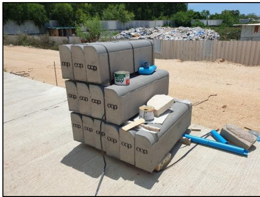
รูปที่ 3-4 ตัวอย่างระบบสำเร็จรูปหรือกึ่งสำเร็จรูป ให้มีการหล่อคอนกรีตในพื้นที่ก่อสร้างน้อยที่สุด
