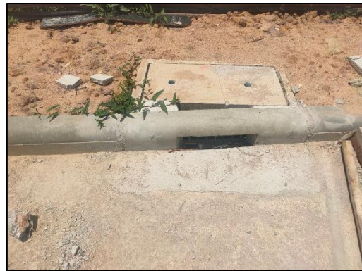
รูปที่ 3-4 ตัวอย่างระบบสำเร็จรูปหรือกึ่งสำเร็จรูป ให้มีการหล่อคอนกรีตในพื้นที่ก่อสร้างน้อยที่สุด
